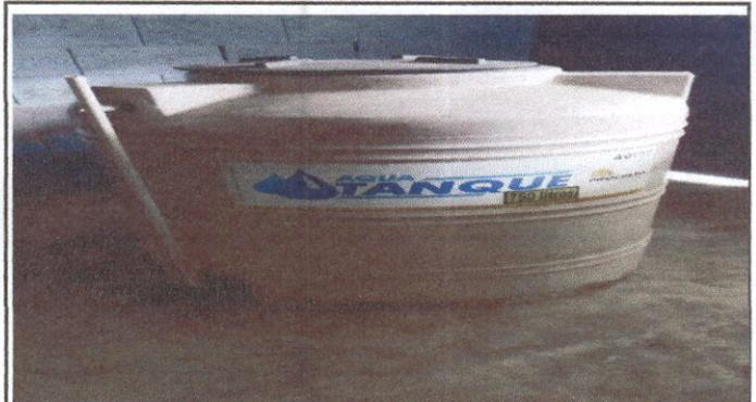
Foto 4: Sustitución de deposito de agua 1100 lt
